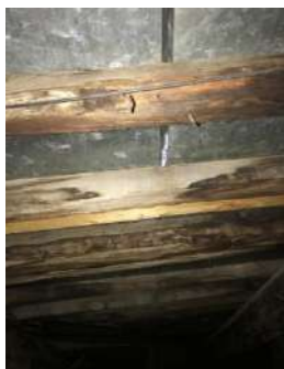
Фото 29 – разрушение стропил и мест крепления кровельного покрытия
