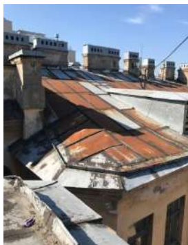
Фото 29 – разрушение стропил и мест крепления кровельного покрытия
