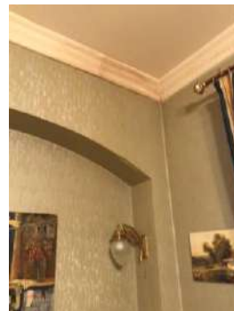
Фото 8 – отслоение гипсовой отделки на фризе
